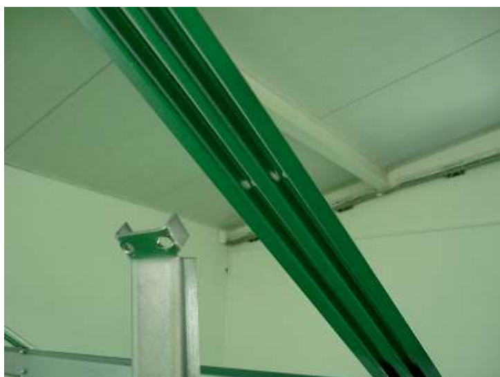
Spojení střešní výztuhy (24) a střešního sloupku (15).
