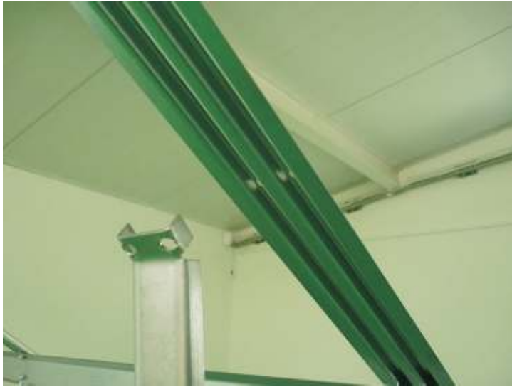
Spojení střešní výztuhy (24) a střešního sloupku (15).
