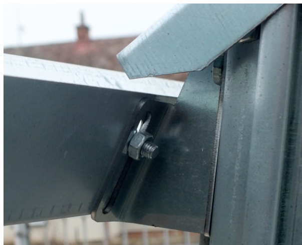
Montáž okapu na držák okapu
