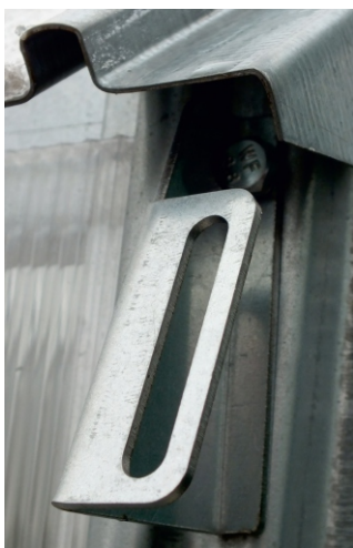
Montáž držáku okapu
